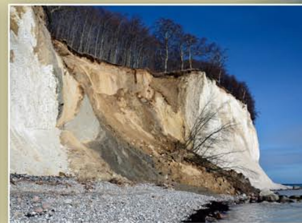
Rutschung von eiszeitlichen Ablagerungen am südlichen Wissower Ufer. – April 2011
