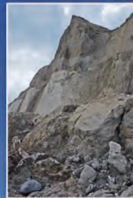
Abbruch unterhalb des Burgwalles
