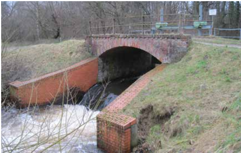
Abbildung 13: Massiver Sohlabsturz in der Sude bei Brömsenberg (2012) Foto: Martin Krappe
