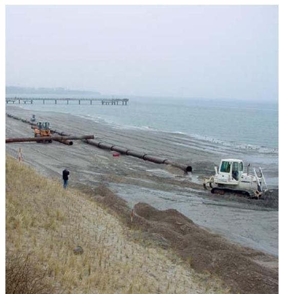
**Abb. 5:** Marine Sandlagerstätten werden wie hier bei Rerik (Landkreis Rostock) vorrangig für Strandaufspülungen zum Küstenschutz genutzt (Foto: 1998).
