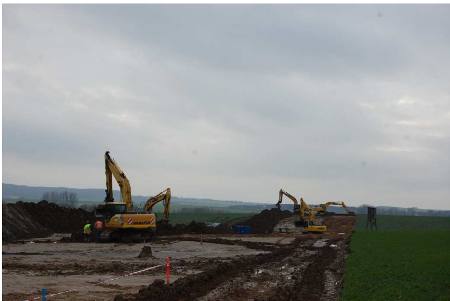
Abb. 4: Während der baubegleitenden Ausgrabungen herrschte auf den Flächen deutlich mehr Betrieb als bei den früheren Grabungen.
