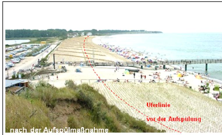
Abb. 39: Aufnahme der Düne in Rerik nach der Aufspülmaßnahme 2013.
