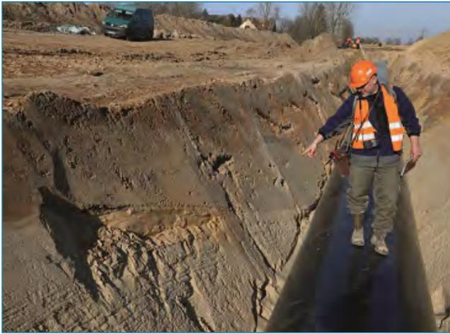
Abb. 3: Bodenkundliche und geologische Untersuchungen im Schurf der Erdgastrasse EUGAL (Foto: K. Obst, 2019)
