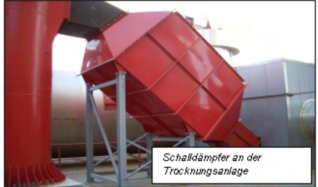
Die Auswertung der Daten ergab in der ungünstigsten Nachtstunde einen Beurteilungspegel von 52 dB(A), welches eine erhebliche Überschreitung des Immissionsrichtwertes nachts der TA Lärm von 45 dB(A) bedeutet. Als Störenfriede wurden schnell Lüftungs- und Trocknungsanlagen entlarvt, die nicht nur zu laut waren, sondern darüber hinaus auch ein tonales Geräusch bei einer Frequenz von 222 Hz verursachten, das die Anwohner so nervte.
