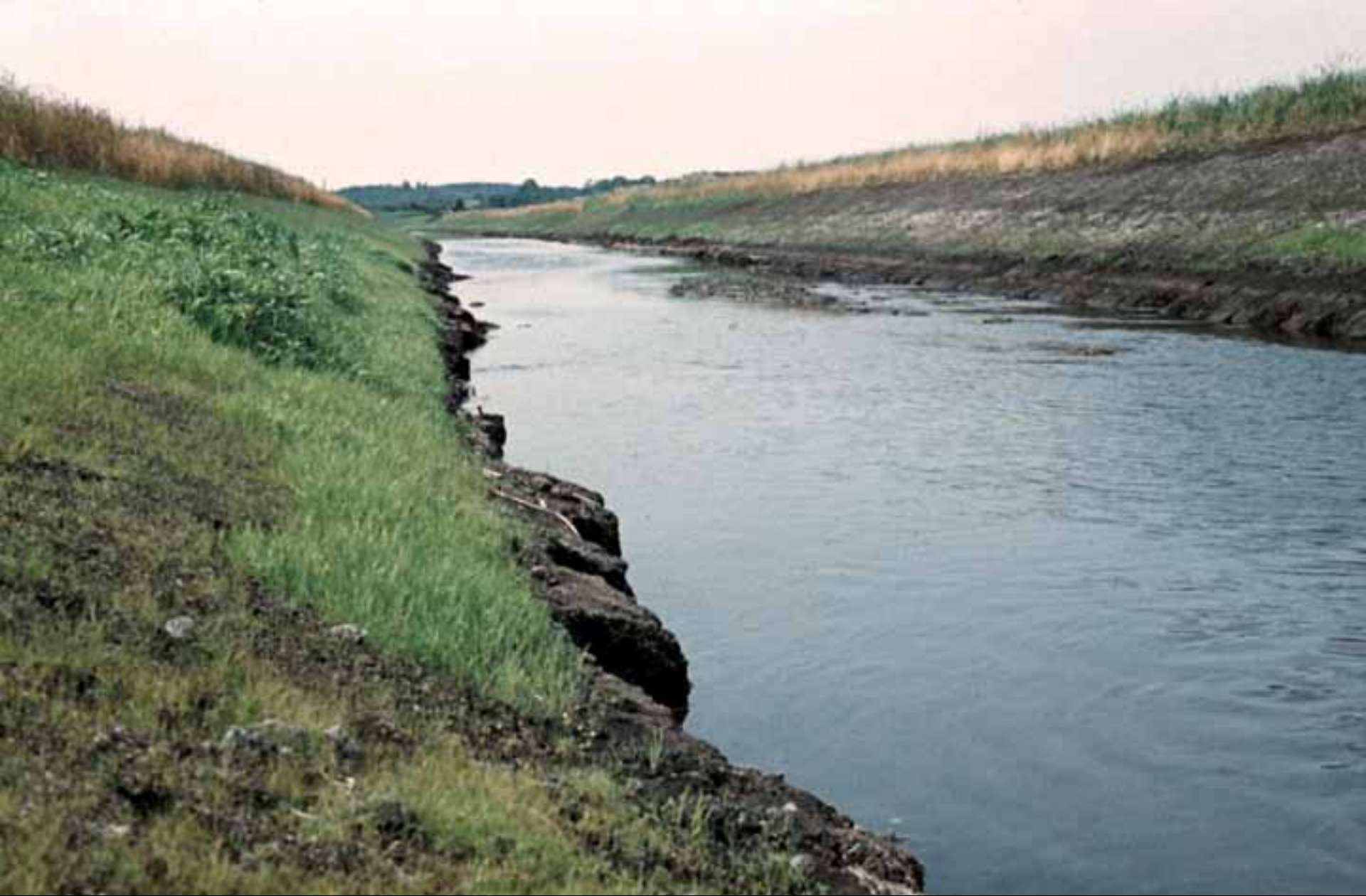
Komplexmelioration der Randow-Welse-Niederung (Uckermark). Ein neues Flussbett wurde in den Torfkörper gegraben, der Grundwasserstand über 2 m tief abgesenkt, die Moore sollten „ausbluten“. (Foto: M. Succow, 1. Mai 1972)
