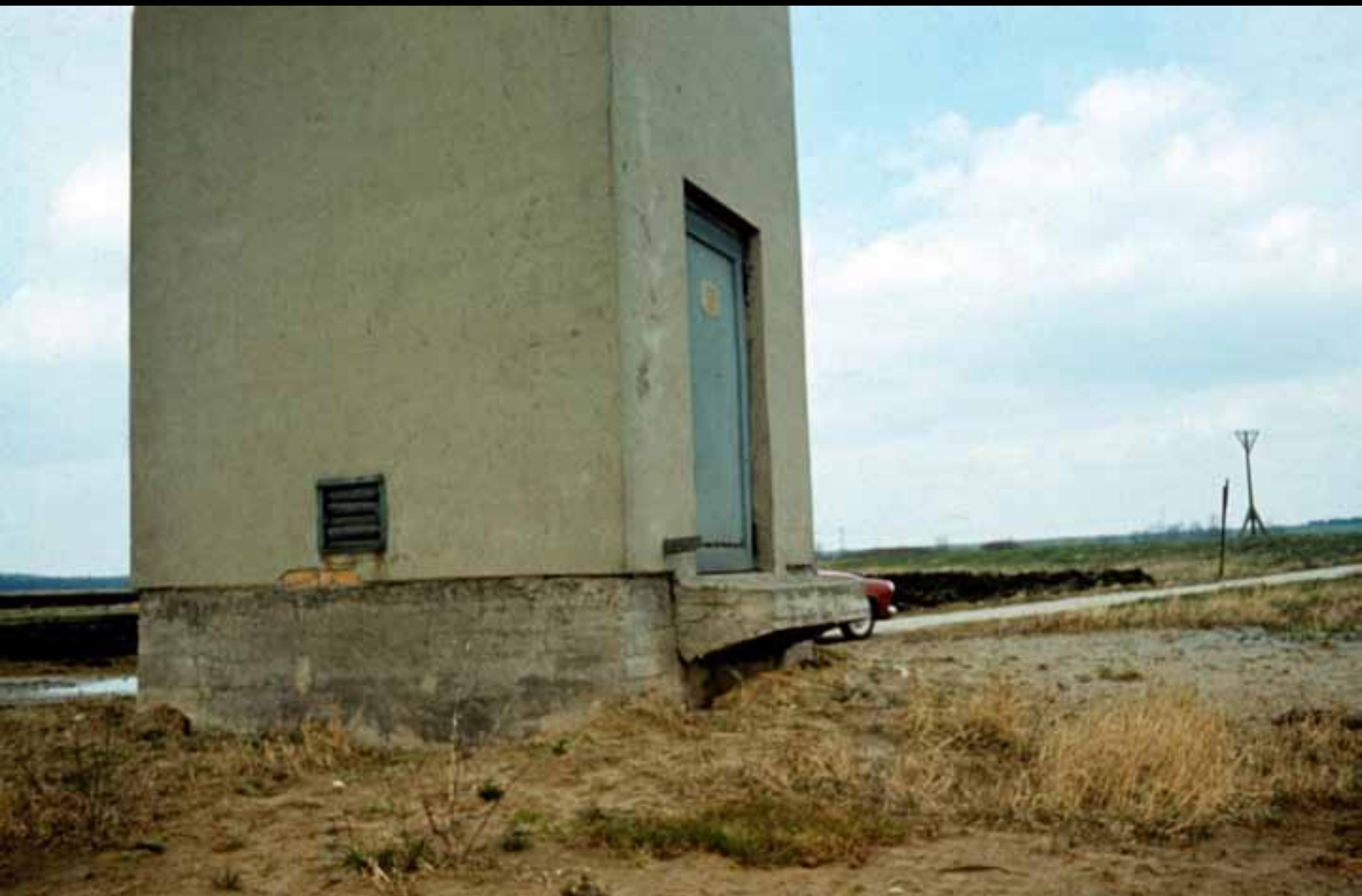
Moorschwund von 0,8 m, 10 Jahre nach der Komplexmelioration: Großer Rosin/ Kummerower See – der Einstieg zum Transformationshaus „hängt“ in der Luft. (Foto: M. Succow, Mai 1978)
