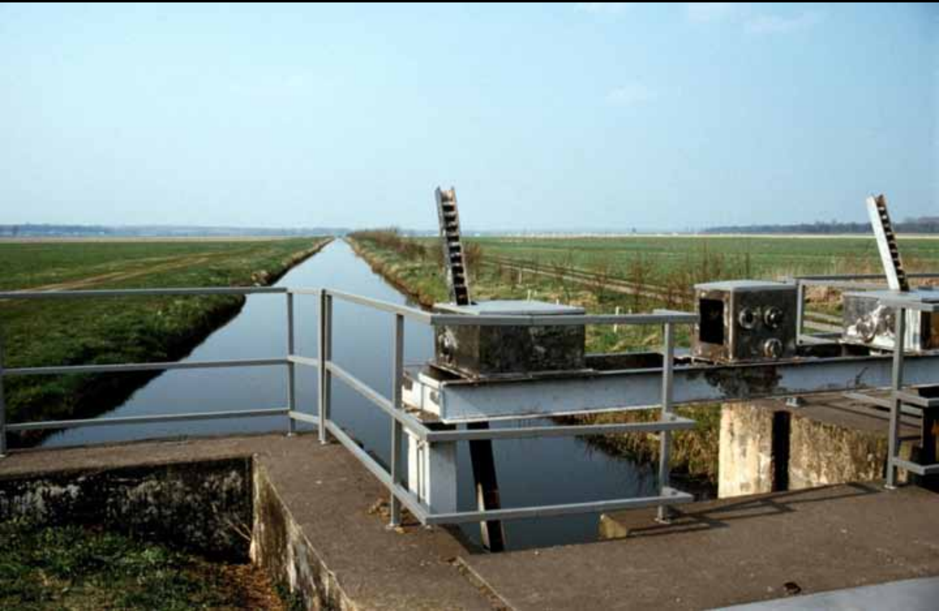
Randow-Niederung bei Schönermark mit eingebautem Staubauwerk, 22 Jahre nach der Komplexmelioration. (Foto: M. Succow, 01. Mai 1994)
