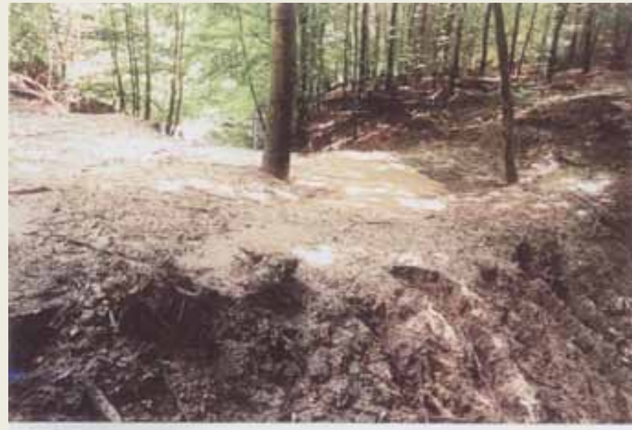
4.60 Postbrücher, erneuerter Erdstau im Entwässerungsgraben
