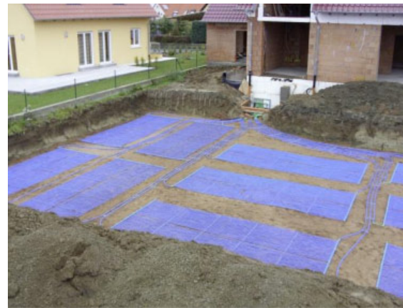
Abb. 6: Flächenkollektor für kleine Grundstücke
