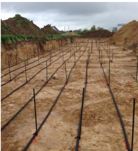
Abb. 5: Flächenhaft verlegte PE-Rohre
