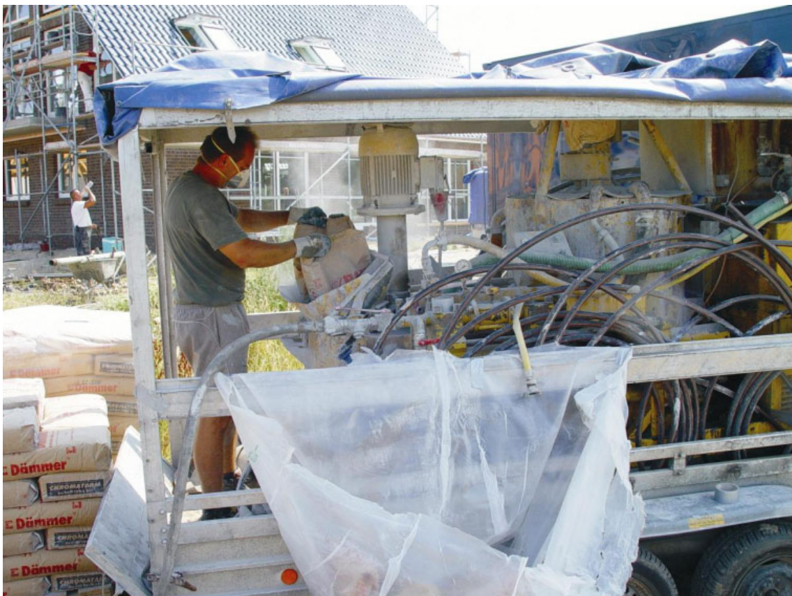
Abb. 17: Herstellung einer Bentonit-Zement-Mischung zum Verpressen
