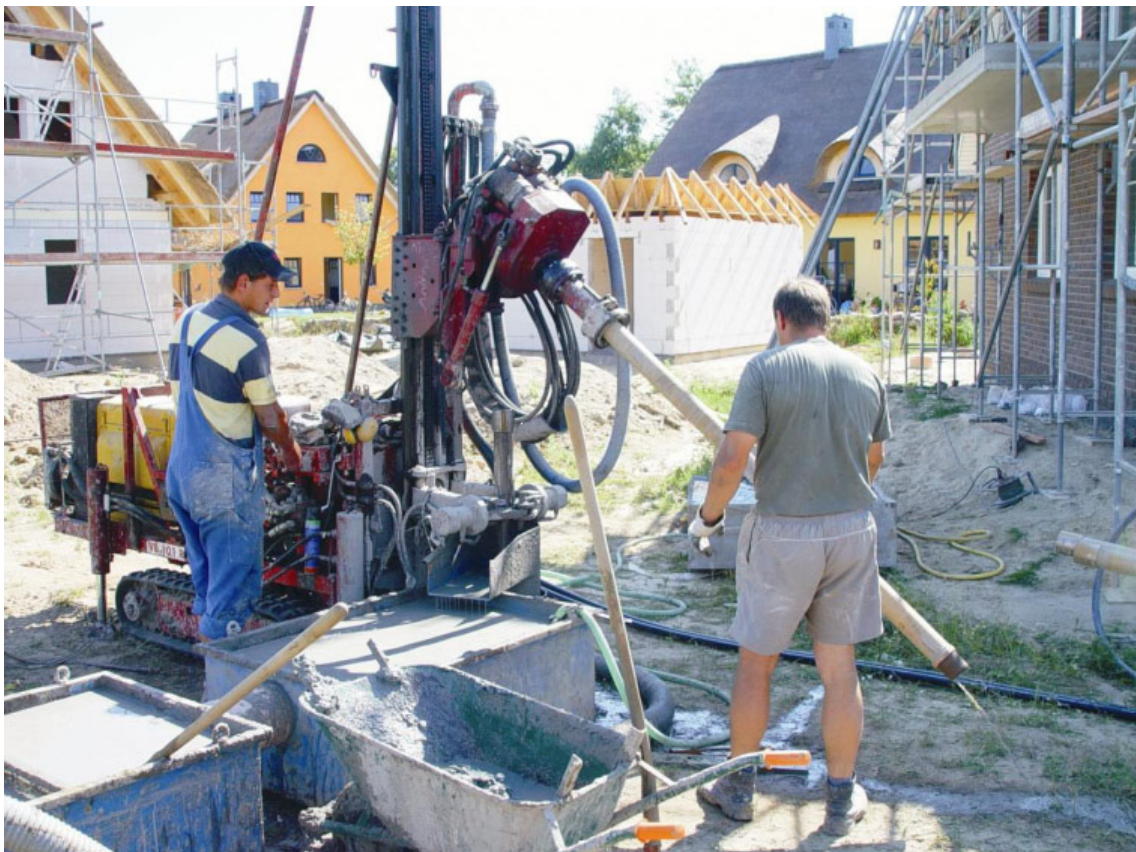
Abb. 14: Abteufen einer Erdwärmesondenbohrung
