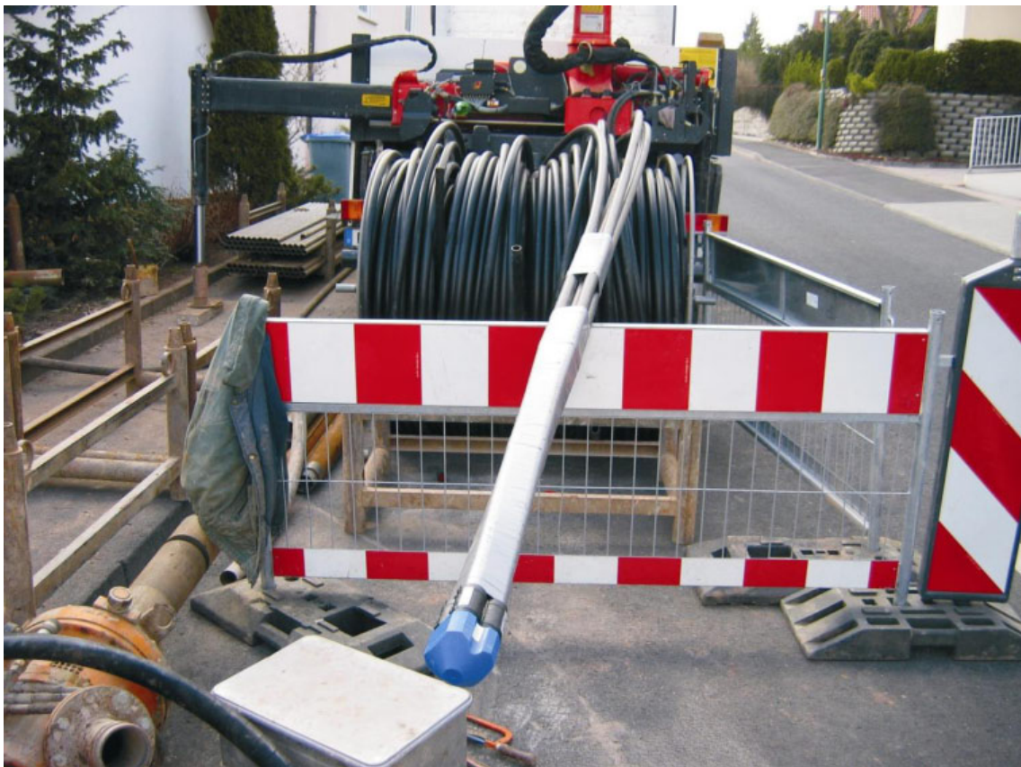
Abb. 3: Konfektionierte Doppel-U-Rohr-Sonde vor dem Einbau in die Bohrung
