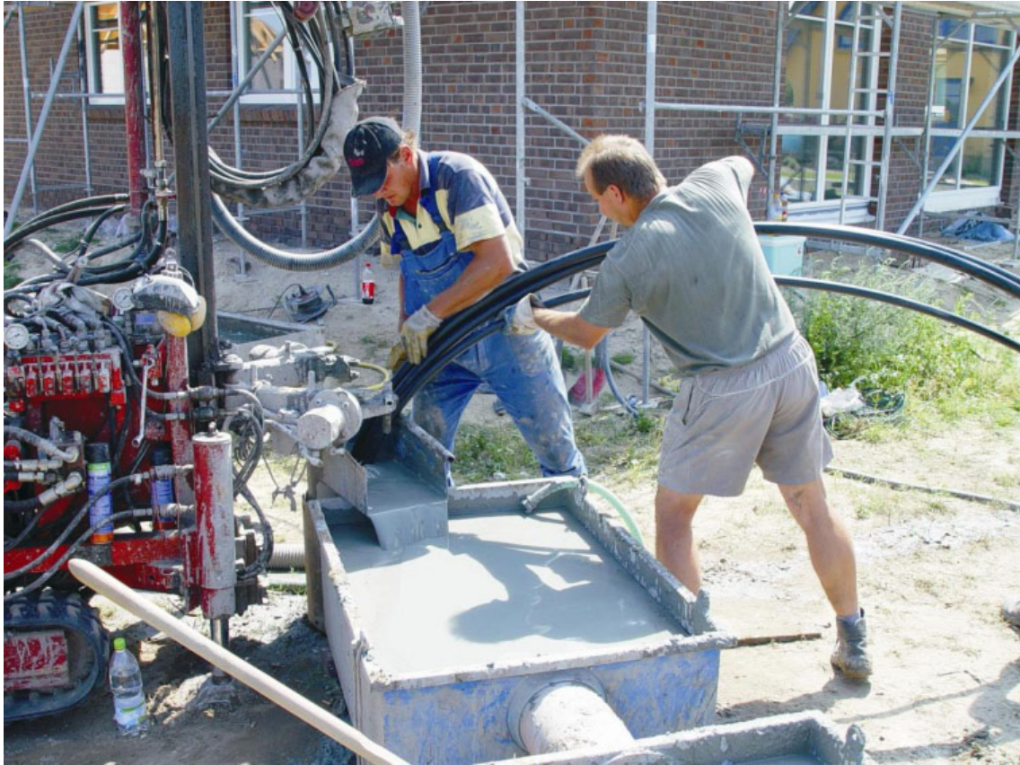
Abb. 16: Einbau einer Erdwärmesonde
