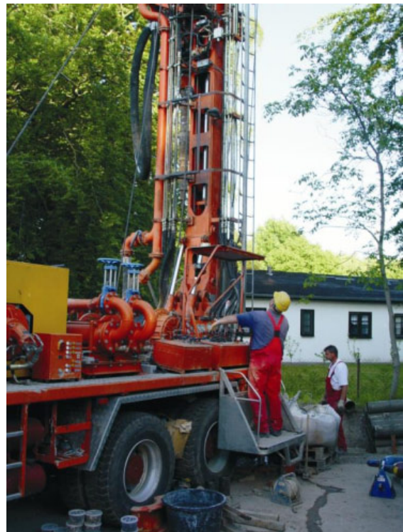
Abb. 13: Bohranlage im Einsatz
