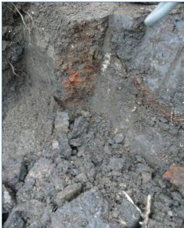
Abb. 66: Schürf 1, 50 cm Tiefe, auch hier keine Risse
