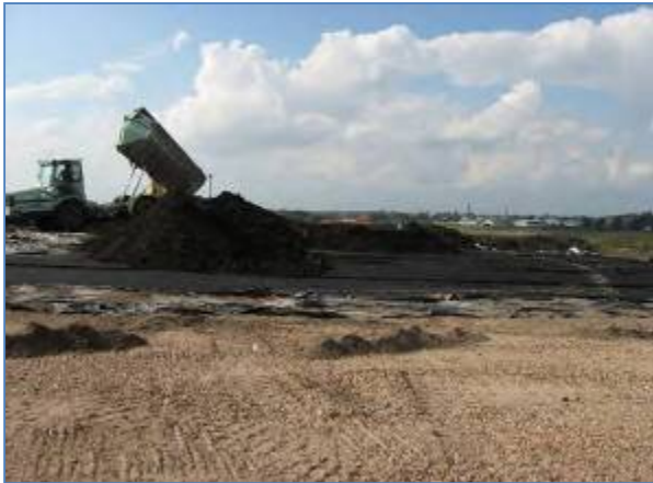
Abb. 72 und 73: Einbau des Baggergutes im Plateaubereich
