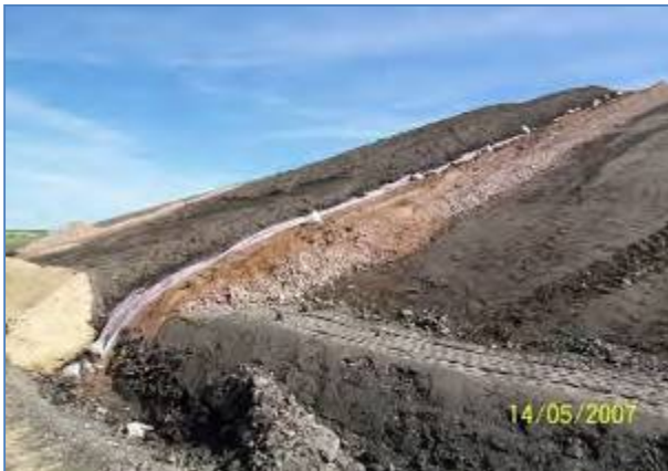
Abb. 74: Aufbau der Oberflächenabdeckung
