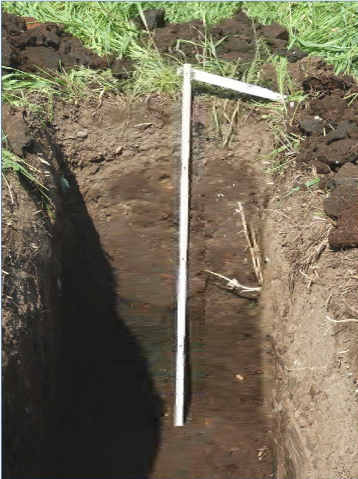
Abb. 96: Schürf bei 80 cm Tiefe, Riss ragt bis zu ca. 75 cm
