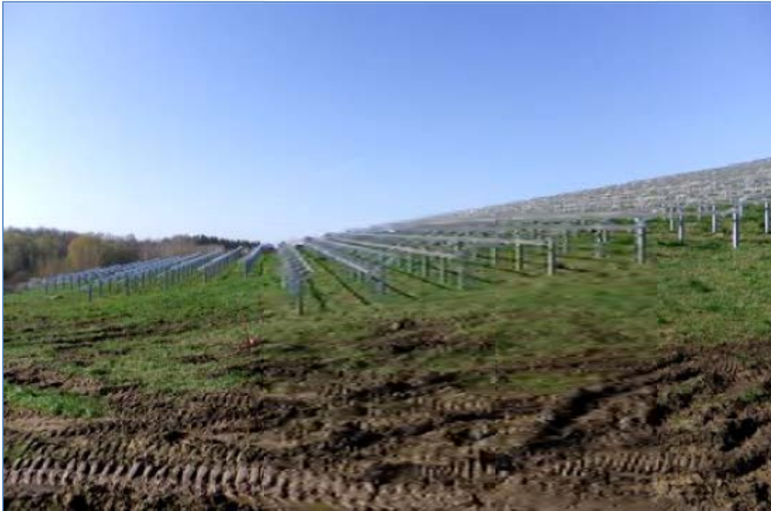
Abb. 14: Im Bau befindliche Photovoltaikanlage
