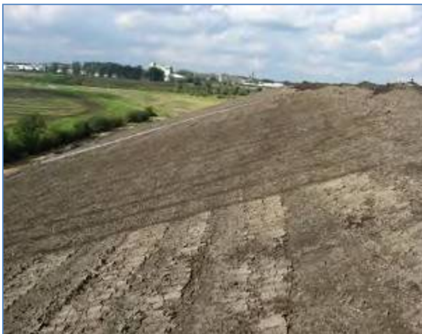
Abb. 76: Mit der Raupe abgezogener Hang
