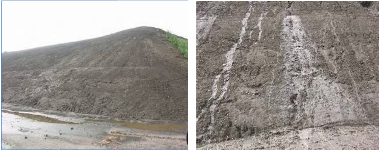
Abb. 59 und 60: Erosionsstabile und standsichere Hangbereiche nach den Starkniederschlägen im August 2006
