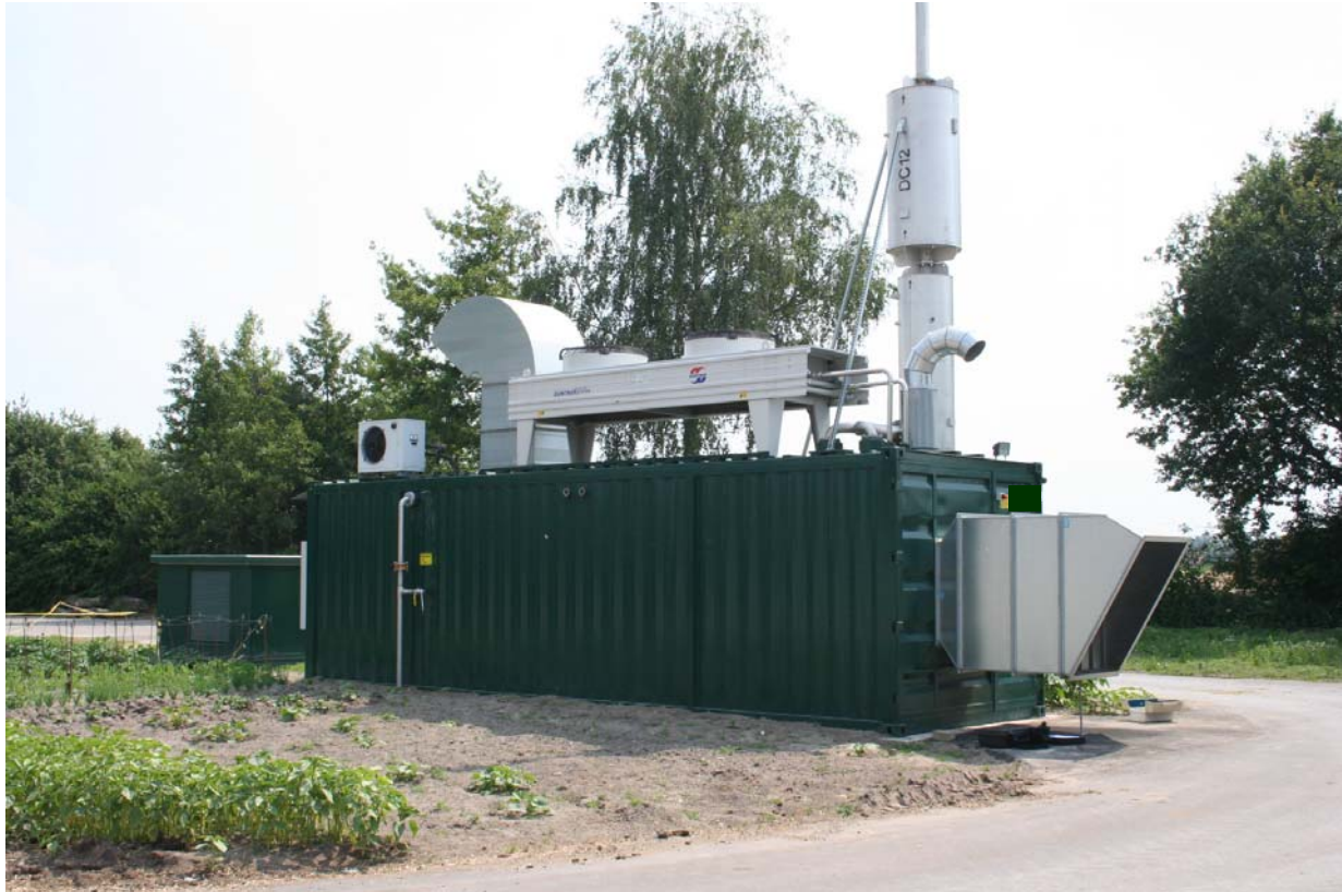
Abbildung 4: BHKW-Stahlblech-Container in Standardausführung
