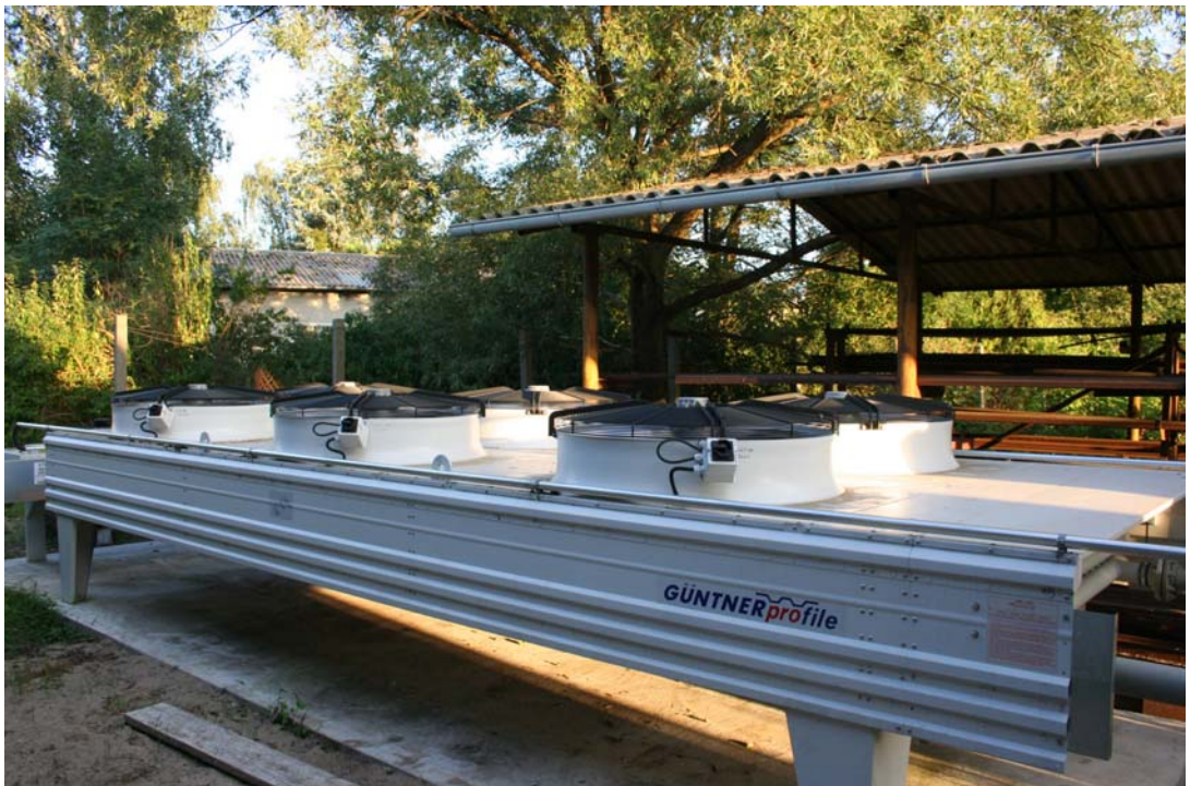
Foto 12: Blick auf eine extrem leise Ausführung eines Notkühlers für einen BHKW-Motor mit einer elektrischen Leistung von 527 kW.
