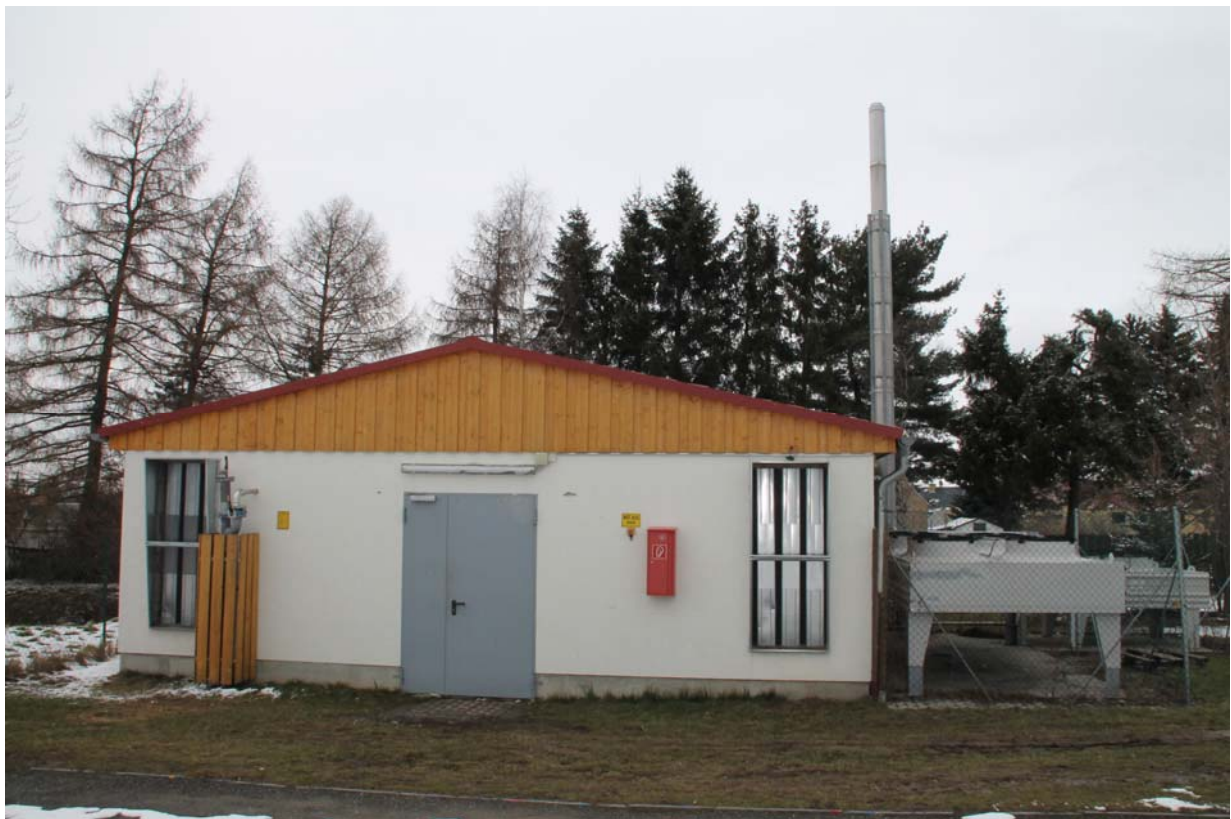
Abbildung 7c: BHKW-Anlage in einem massiven zweischaligen Gebäude
