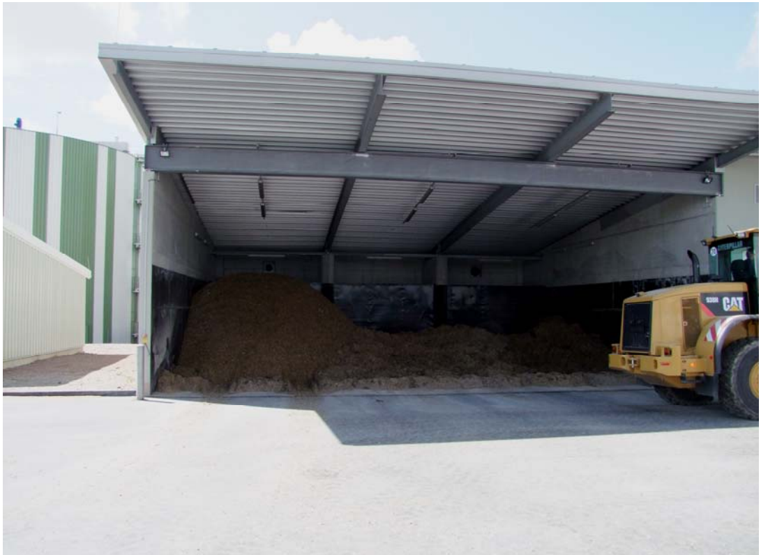
Foto 15: Blick auf einen Feststoffeintrag mit Schubbodensystem, der innerhalb eines massiven Gebäudes errichtet wurde.
