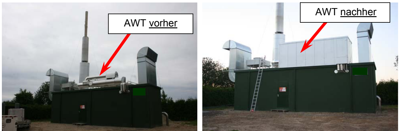
Abbildung 18b: Beispiel für die nachträgliche Einhausung eines Abgaswärmetauschers auf dem Dach einer BHKW-Betonschallhaube - als begehbare Ausführung
