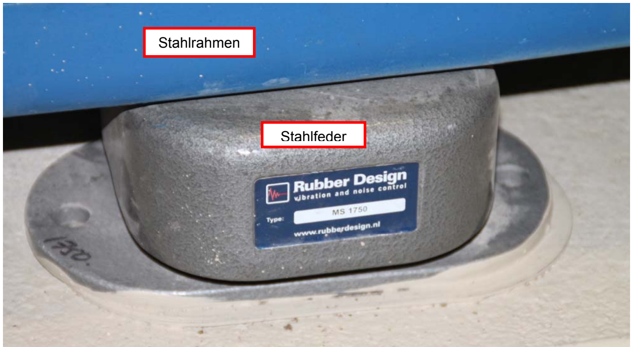
Abbildung 12: Luftfedern unter dem Stahlrahmen eines BHKW-Motors zur Körperschallentkopplung der Maschine vom Boden der Beton-Schallhaube
