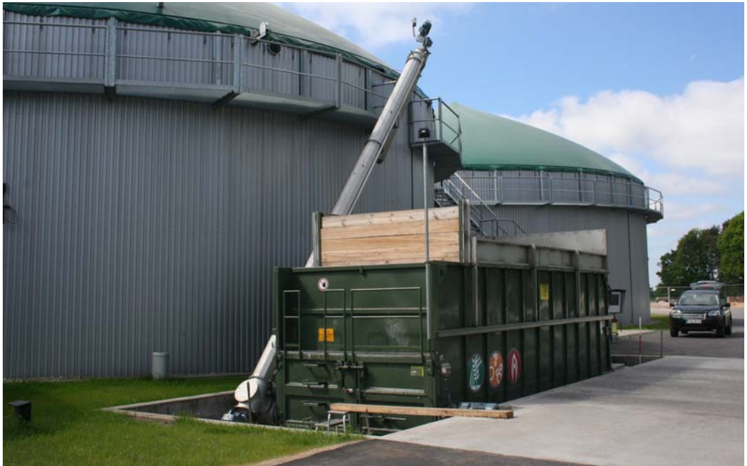
Foto 13: Blick auf einen klassischen Feststoffdosierer und die sich anschließenden Fördereinrichtungen.
