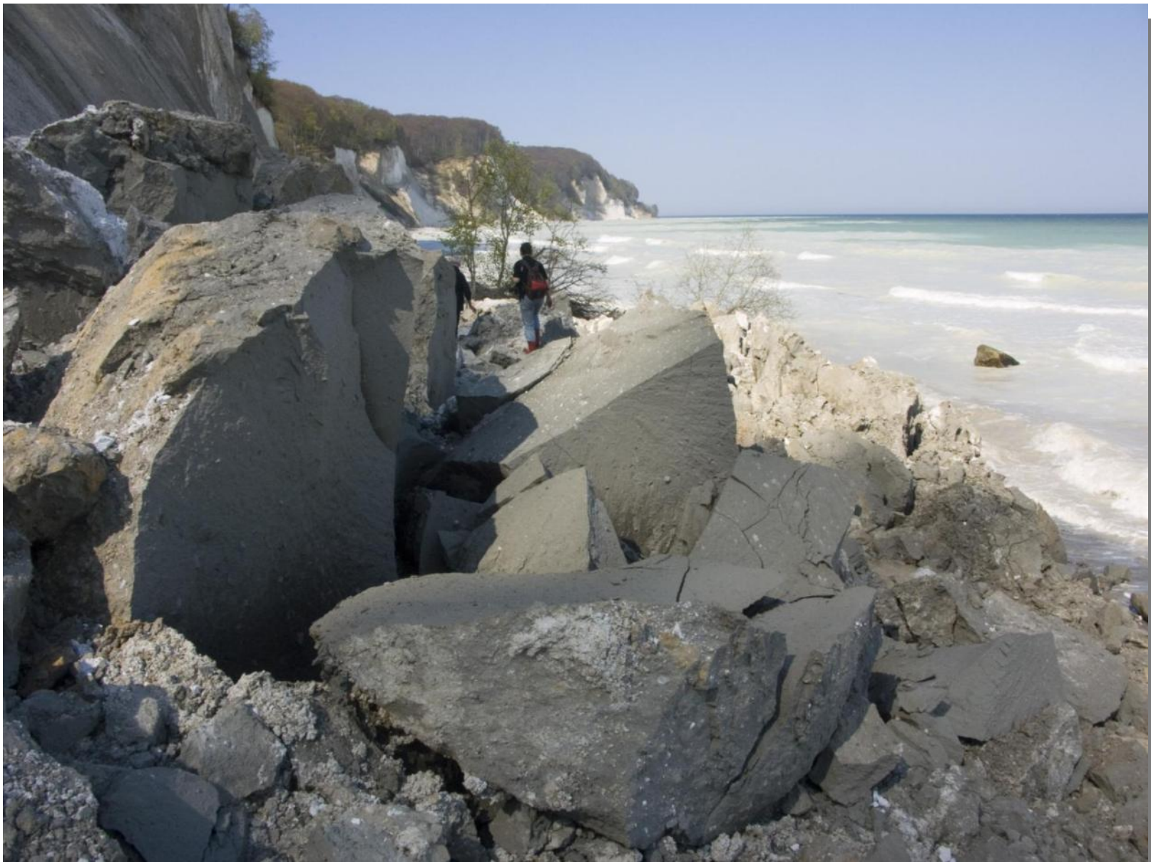
Fahrnitzer Ufer, 29. April 2008
