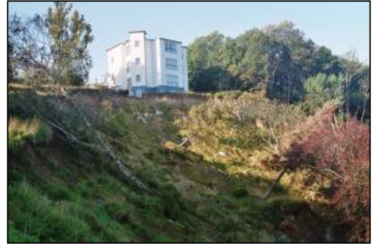
Rutschung in eiszeitlichen Sedimenten (März 05) (Ortslage Lohme)
