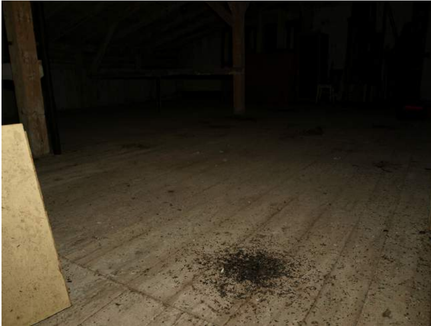
Abb. 41: Blick in Dachboden (unter Doppelbalken) im Specker Schloss.
