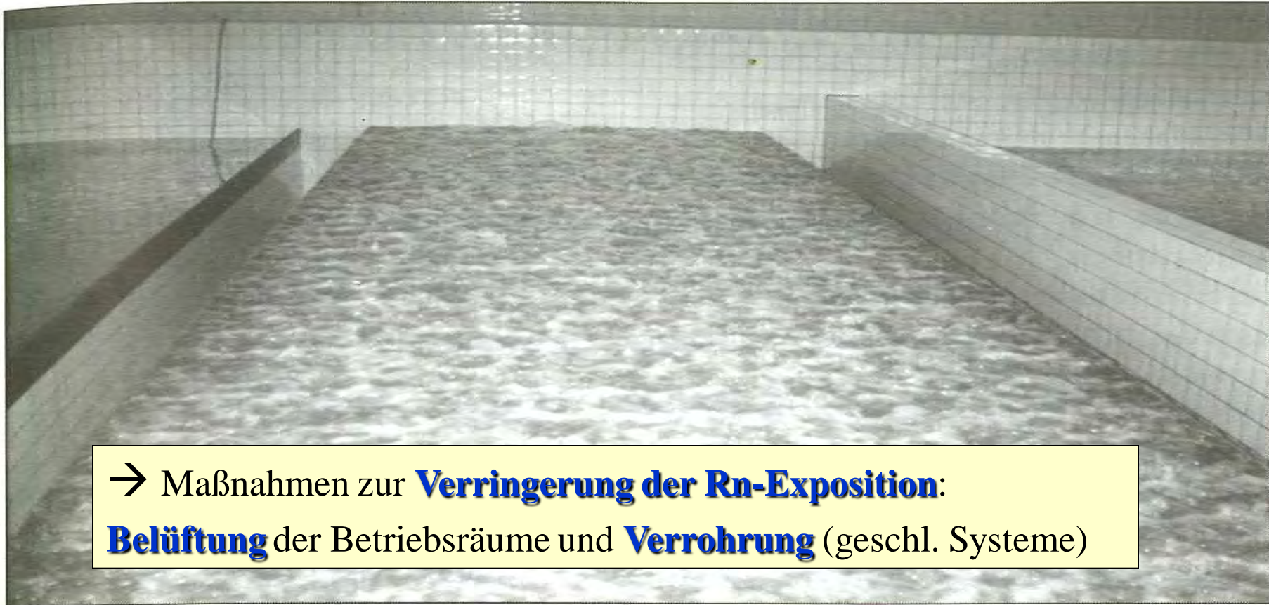
Abb. 2: Rückspülvorgang eines offenen Kiesfilterbeckens mit Luft, links und rechts Kiesfilter im Arbeitszustand
