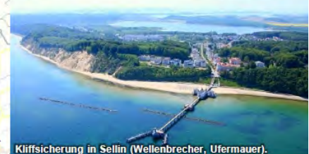
Kliffsicherung in Sellin (Wellenbrecher, Ufermauer).
