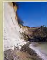
Schreibleie am Dwischen-Kliff nach der Aufarbeitung von Abbruchmassen (November 2002)
