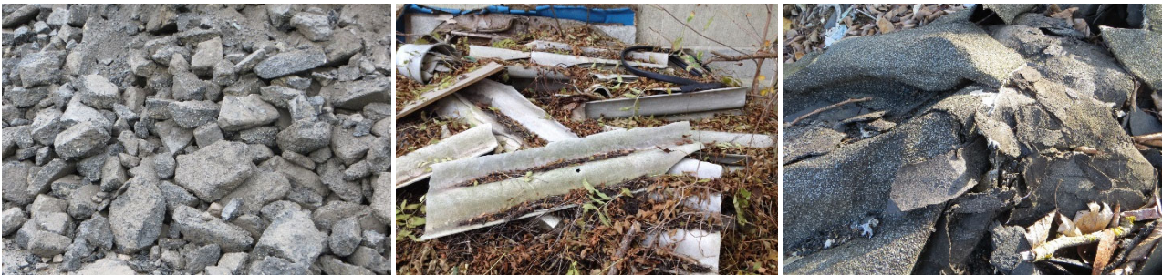
Straßenaufbruch (teerhaltig), Asbest, teerhaltige Dachpappe
