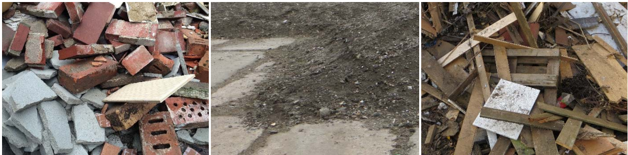
Ziegel- und Betonbruch, Boden, Altholz
