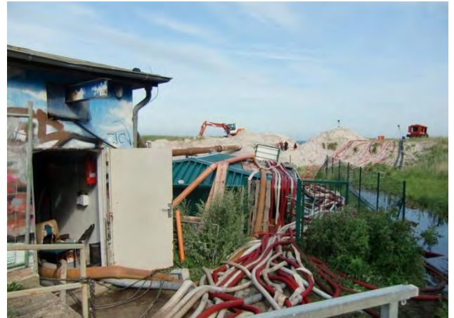
Abbildung 4-15: Geöffnete Hochwasserschutzdüne am Stromgraben (Graal-Müritz) mit zusätzlichen Pumpen/Schläuchen, 30.07.2011, Foto: Institut biota GmbH
