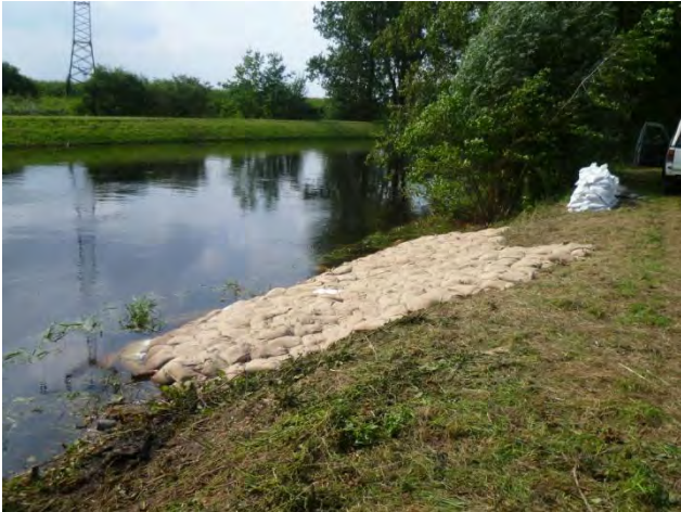
Abbildung 4-17: Am 17.08.2011 erfolgte wasserseitige Deichsicherung am Nebelkanal, Foto: StALU MM (2012)
