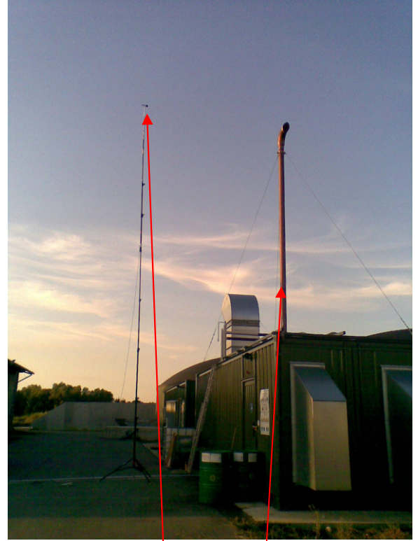
Bild 2: Blick aus südlicher Richtung auf die Anlage (Mikrophon – Kamin)
