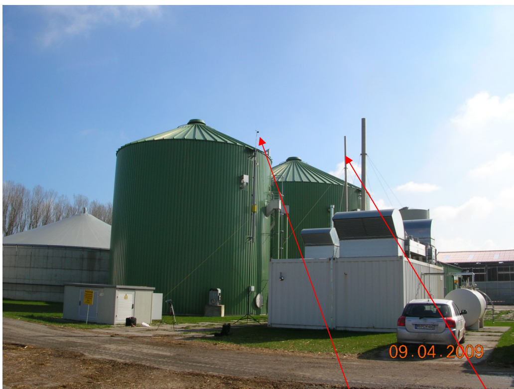
Bild 2: Blick aus südwestlicher Richtung auf die Anlage (Mikrophon - bemessener Kamin)
