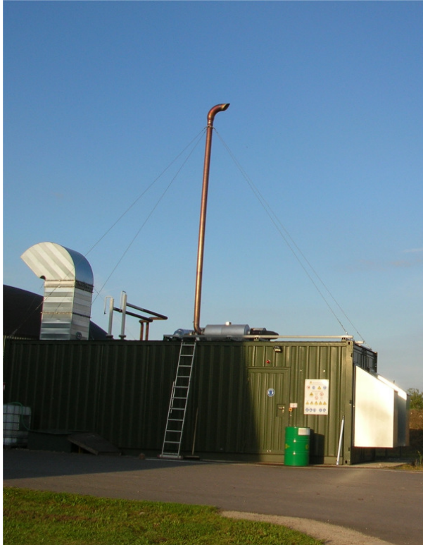
Bild 1: Blick aus westlicher Richtung auf die Anlage (Kamin)
