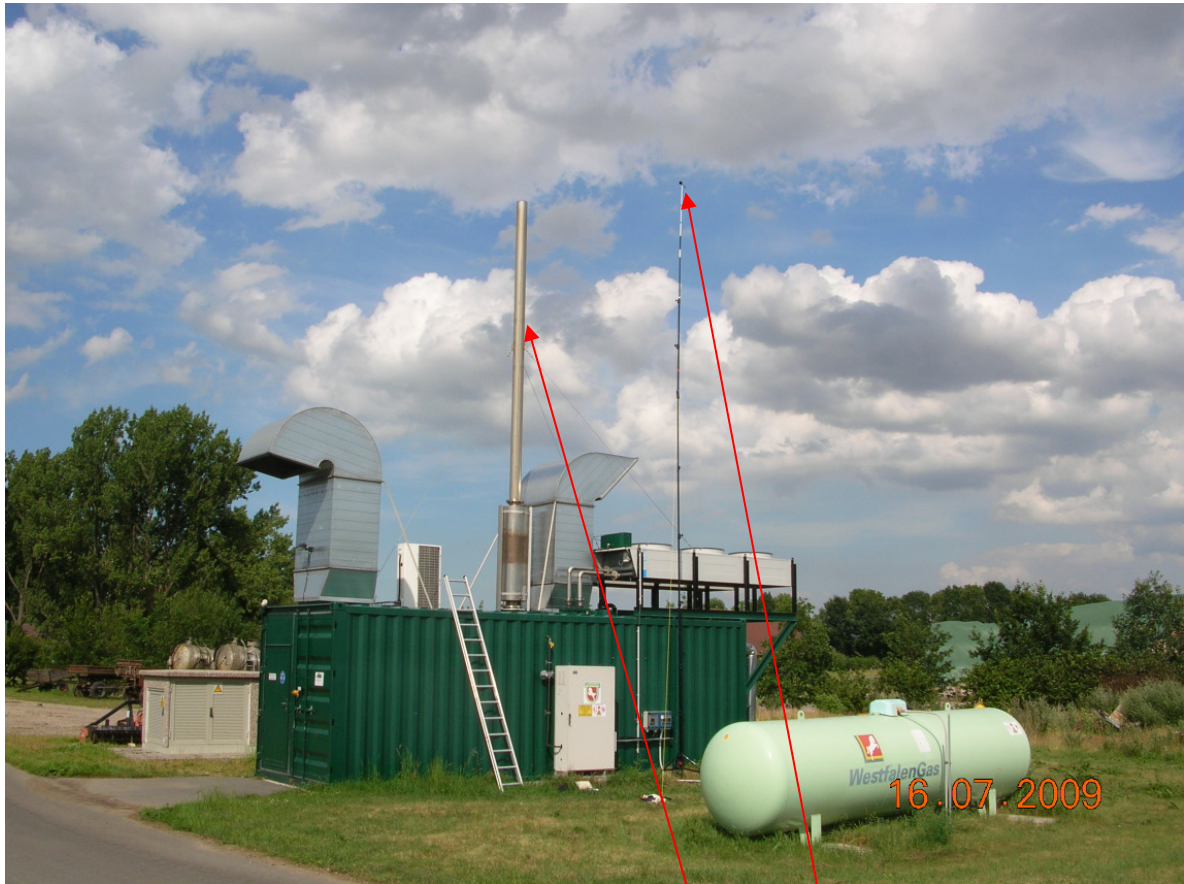
Bild 1: Blick aus südwestlicher Richtung auf die Anlage (Kamin - Mikrophon)
