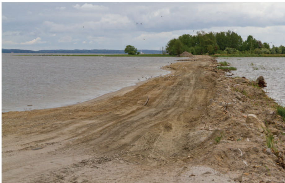
Schicht für Schicht wurde der Damm zur Insel Görmitz abgetragen. Inzwischen ist er verschwunden.
