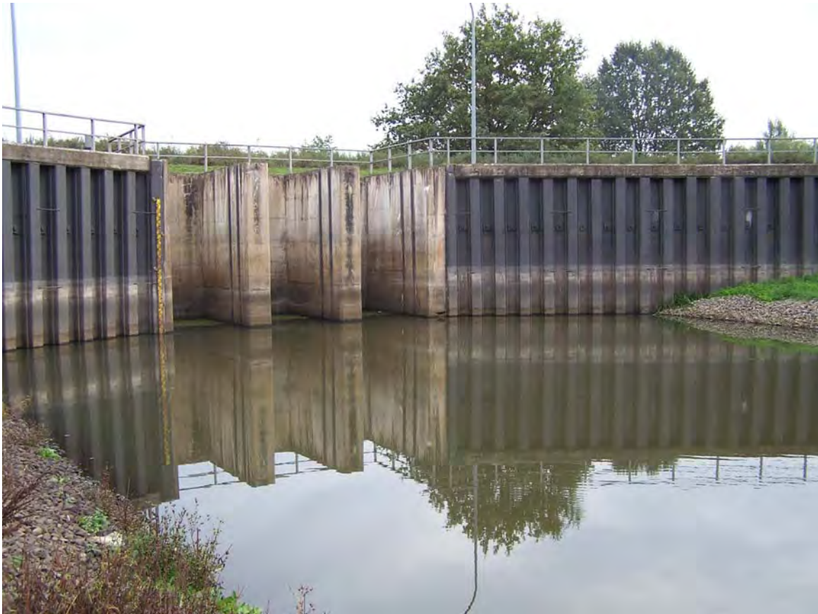
Querbauwerk in der Löcknitz bei Dömitz (Düker) (Foto: T. Schaarschmidt)
