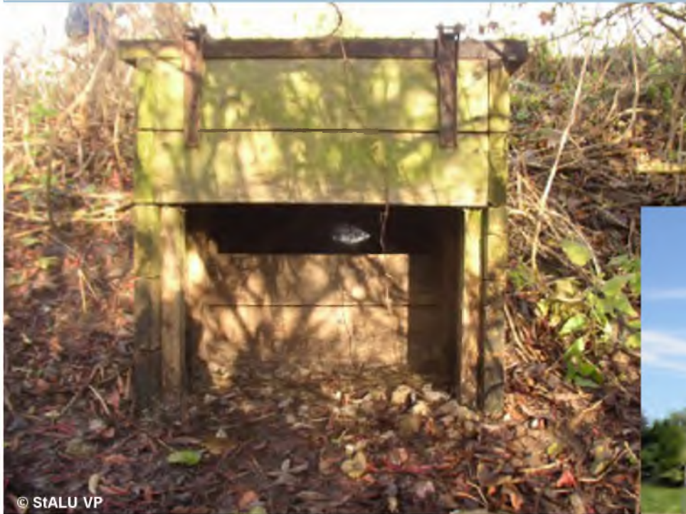
Neubau Wegedurchlass Büschbrück
