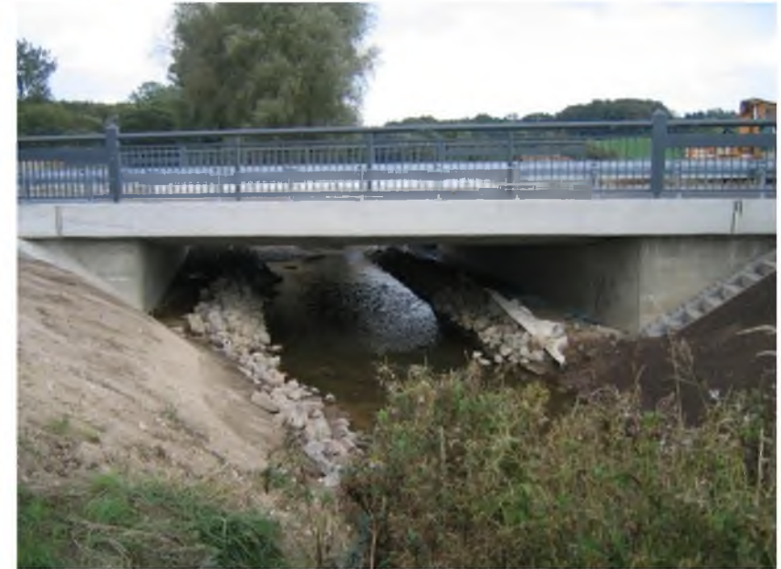
Zustand nach der Wiedervernetzung fischottergerechte Bermen gem. MAQ
