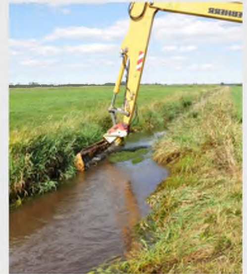
Mähen einer Böschung – und ggf. halbseitiges Krauten der Sohle oder Krauten einer Stromrinne
